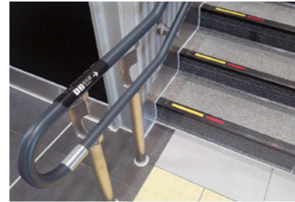
階段の両側2段手すり・段差明示タイル
