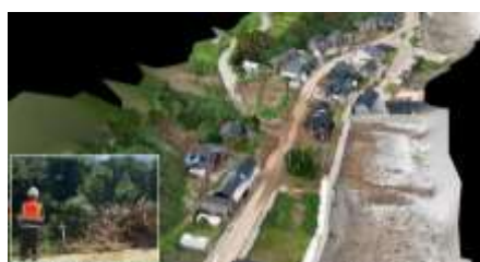
ドローンによる災害調査
