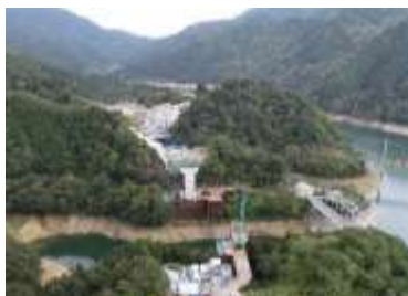
中部縦貫自動車道の整備 （新子馬巣谷橋（仮称））
