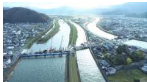
国道162号西津橋、城内橋、大手橋の整備
