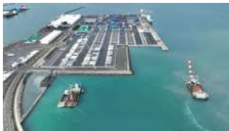
敦賀港鞠山南地区の整備
