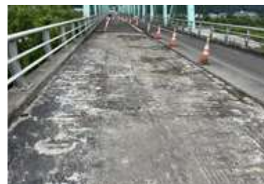
国道416号の橋梁補修（市荒川大橋）
