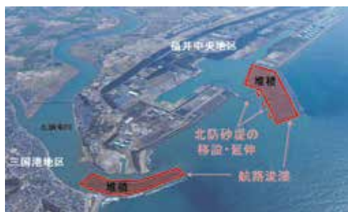
福井港北防砂堤延伸工事
