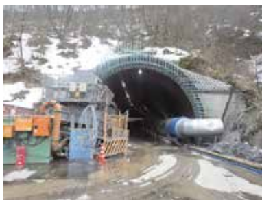
国道417号冠山峠道路の整備
