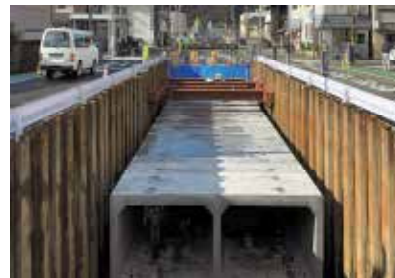
大蓮寺川河川改修（放水路整備）
