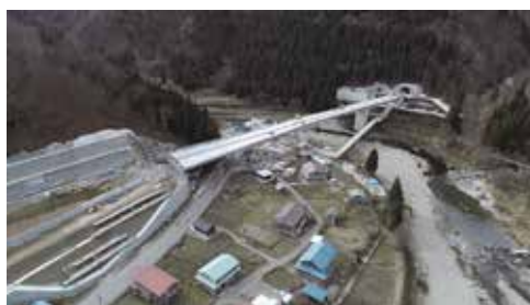
中部縦貫自動車道 九頭竜川橋（仮称）
