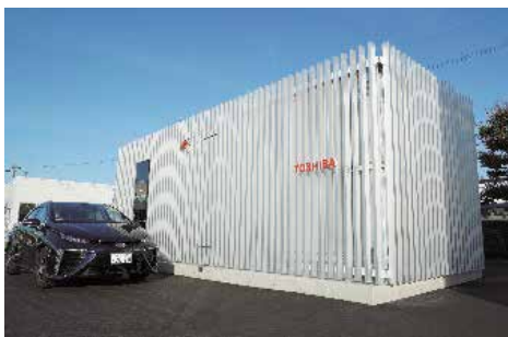
水素ステーション
