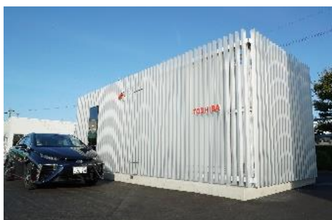
水素ステーション
