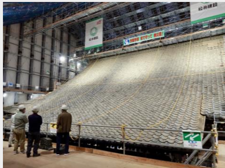
西福寺修理現場見学会
