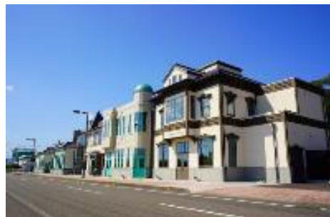
4棟復元による新ムゼウムの整備(敦賀市)
