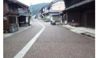
北国街道の道路空間整備
