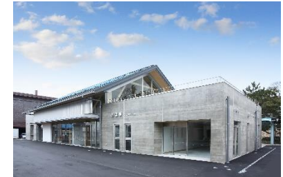
えちぜん鉄道三国駅舎の整備
