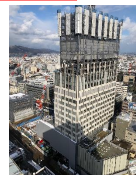
北地区A街区写真 (R5.2.21 ハピリン屋上より撮影)
