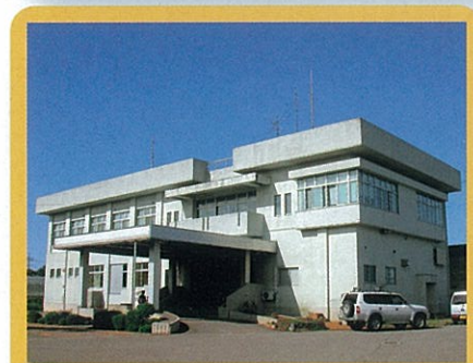
④坂井市三国上下水道管理センター (2,500m 3 ×2池)
