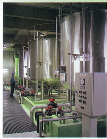
薬品貯蔵施設
