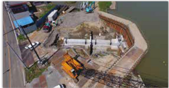
県営湛水防除事業 加戸排水地区
