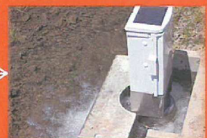
③圃場近くに設置されたゲートウェイを経由して各給水栓へ伝達。
