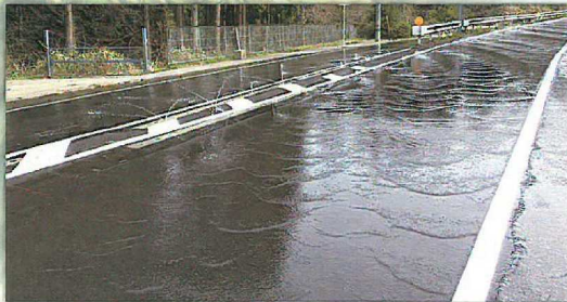
県営農道保全対策事業 坂井北部2期地区
