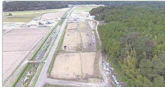
県営経営体育成基盤整備事業 柿原地区
