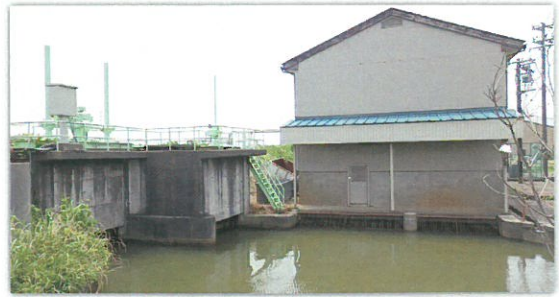
県営湛水防除事業 加戸排水地区
