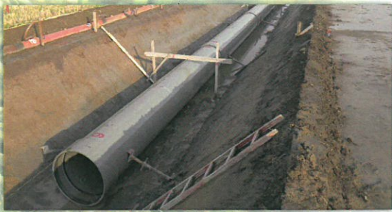
県営かんがい排水事業 五ヶ江地区
