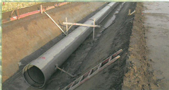
県営かんがい排水事業 五ヶ江地区
