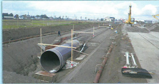
県営かんがい排水事業 西江・中江地区
