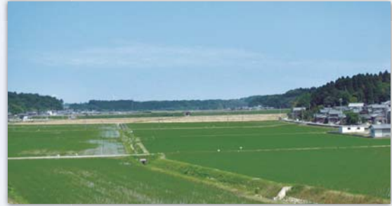
県営経営体育成基盤整備事業 滝地区
