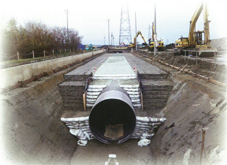
農業用水路のパイプライン化
