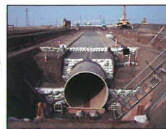
かんがい排水事業西江・中江地区 パイプライン(FRP管φ2000mm)設置状況
