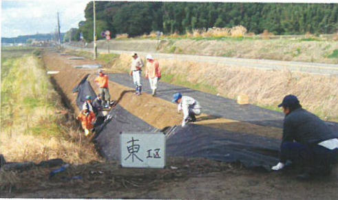
★防草シートによる きめ細やかな雑草対策
