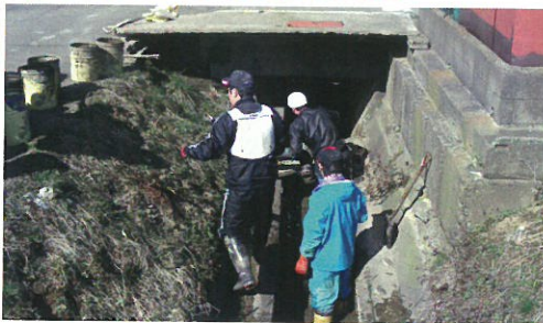
★水路の泥上げ作業
