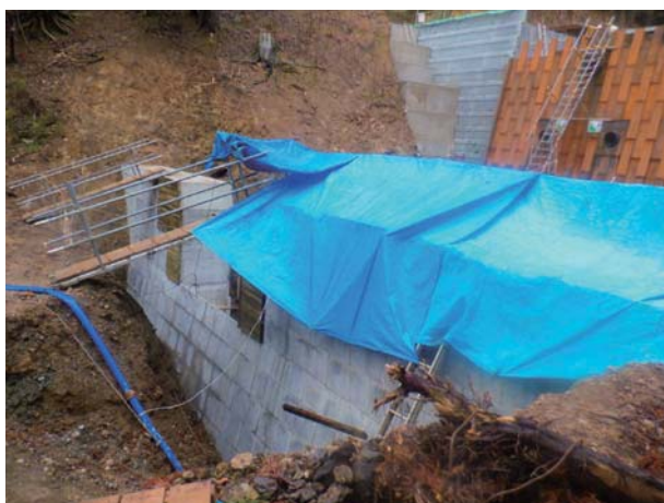
堀川 砂防堰堤（若狭町小川） （令和3年度 工事中）
