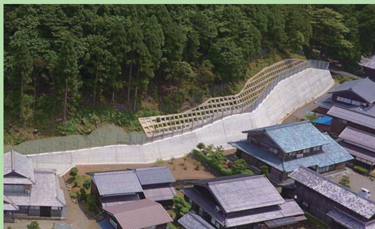
うりゅう 瓜生地区 (若狭町瓜生) [重力式擁壁工、法枠工]
