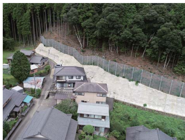
福谷地区 崩壊土砂防護柵（おおい町福谷） （令和3年度 工事中）
