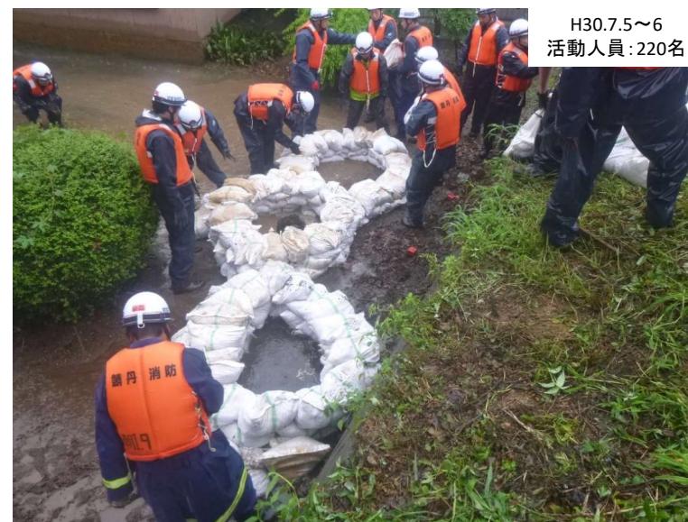
釜段工法による水防活動(越前町)
