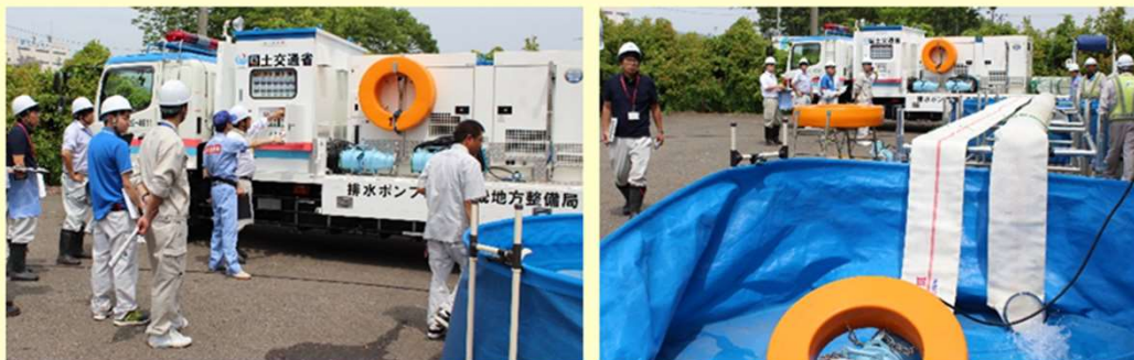
自治体職員による排水ポンプ設置・撤去実習
