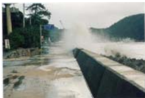
敦賀港海岸（常宮地区）
