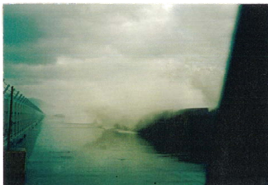
福井港海岸 における越波状況
