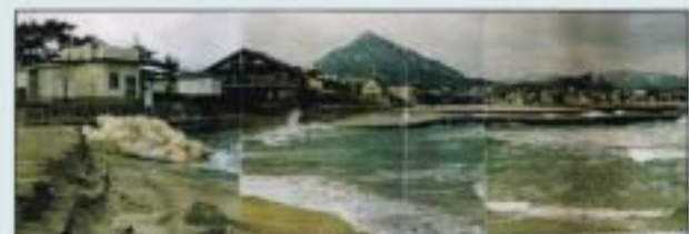
■冬季風浪等により砂浜の侵食が進行します。 和田港海岸
