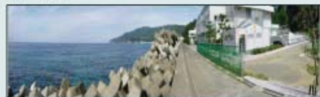
■越波対策として護岸や消波工の整備をしています。 厨海岸
