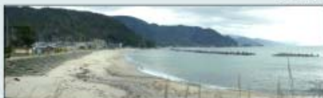
■侵食対策として沖合いに離岸堤の整備をしています。 竹波海岸
