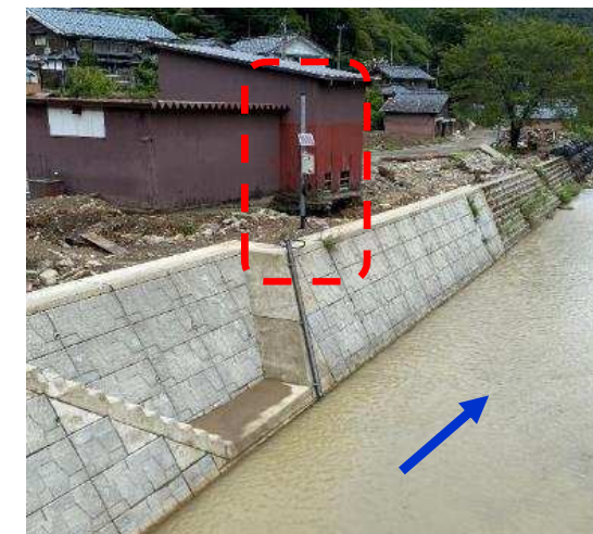
水位計の設置(R4.8.26設置)
