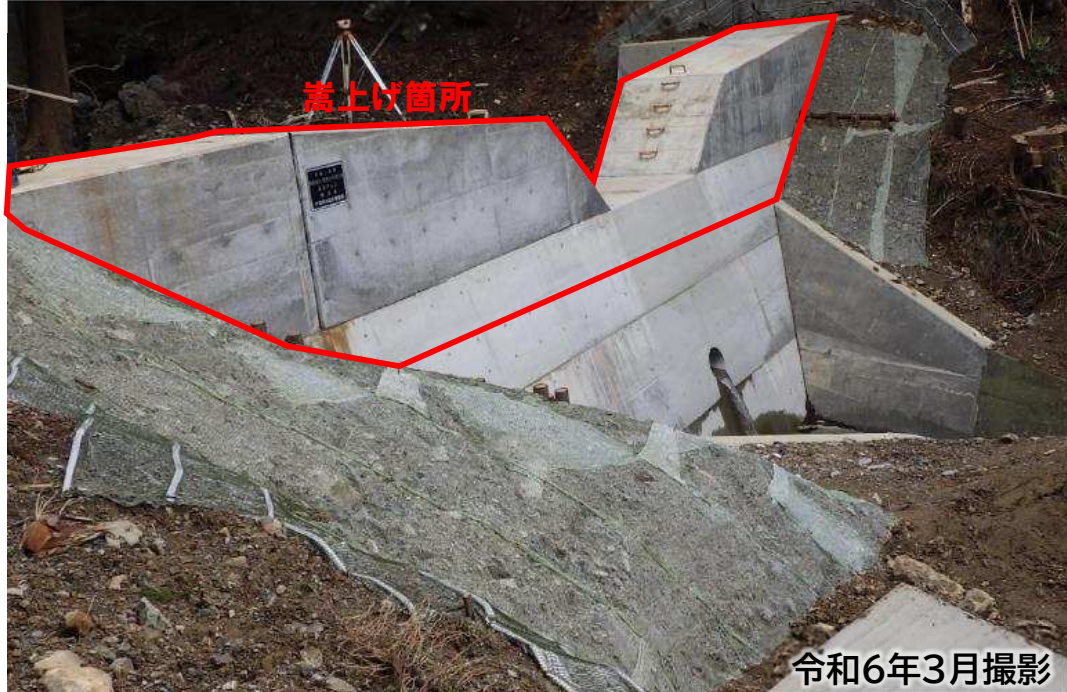
治山ダム嵩上げ(新道地区)
