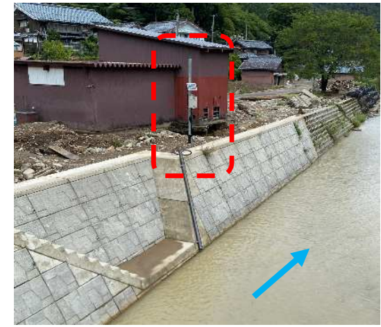
水位計の設置（R4.8.26設置）
