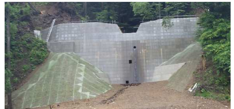
工事完了：治山ダム嵩上（新道地区）
