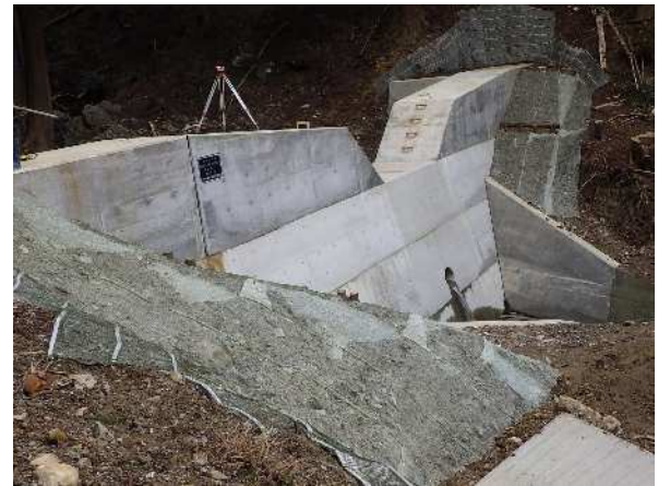
鹿蒜川（南今庄地区） 工事完了：治山ダム嵩上（南今庄地区）
