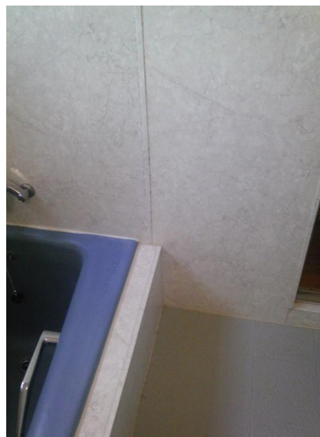
元山氏が県内で初めて取り入れた新技術の「パロアコンフォートパネル」工法(カッターでも切れる軽量素材を貼りつけるもので、工期が短く、耐久性に優れ、メンテナンスが簡単)の施工後の浴室の写真
