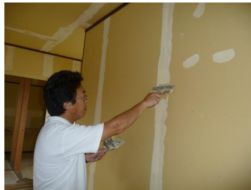
クロス貼り前のパテ詰めなどの下処理作業
