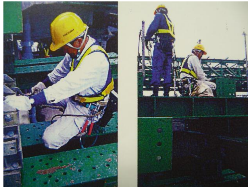
鉄骨架設桁の組立て作業
