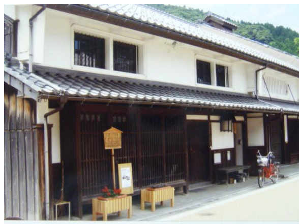
熊川宿 旧逸見邸の漆喰仕上げ
