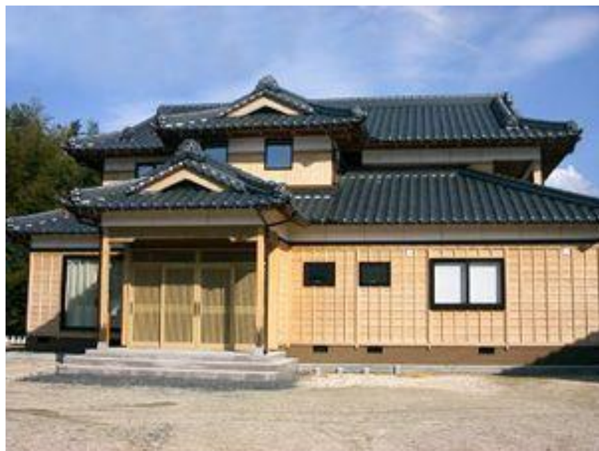
平成16年施工の風格のある純和風住宅 本屋は入母屋造り、玄関はメノコ付照り屋根工法で、 外壁は杉板を使用した鎧下見張り
