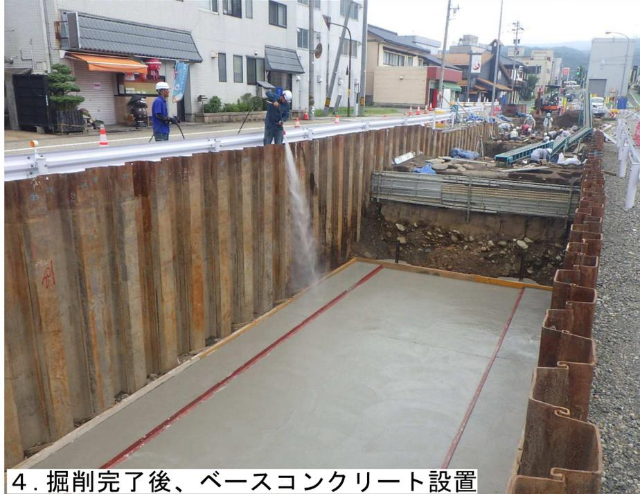
4. 掘削完了後、ベースコンクリート設置
