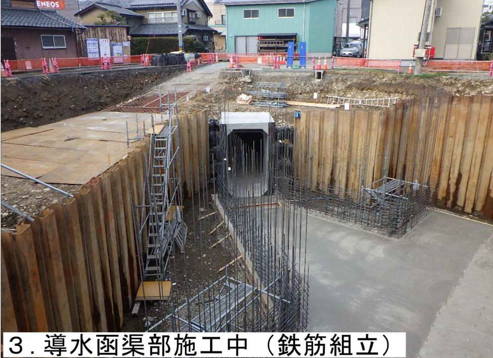
3. 導水函渠部施工中（鉄筋組立）
