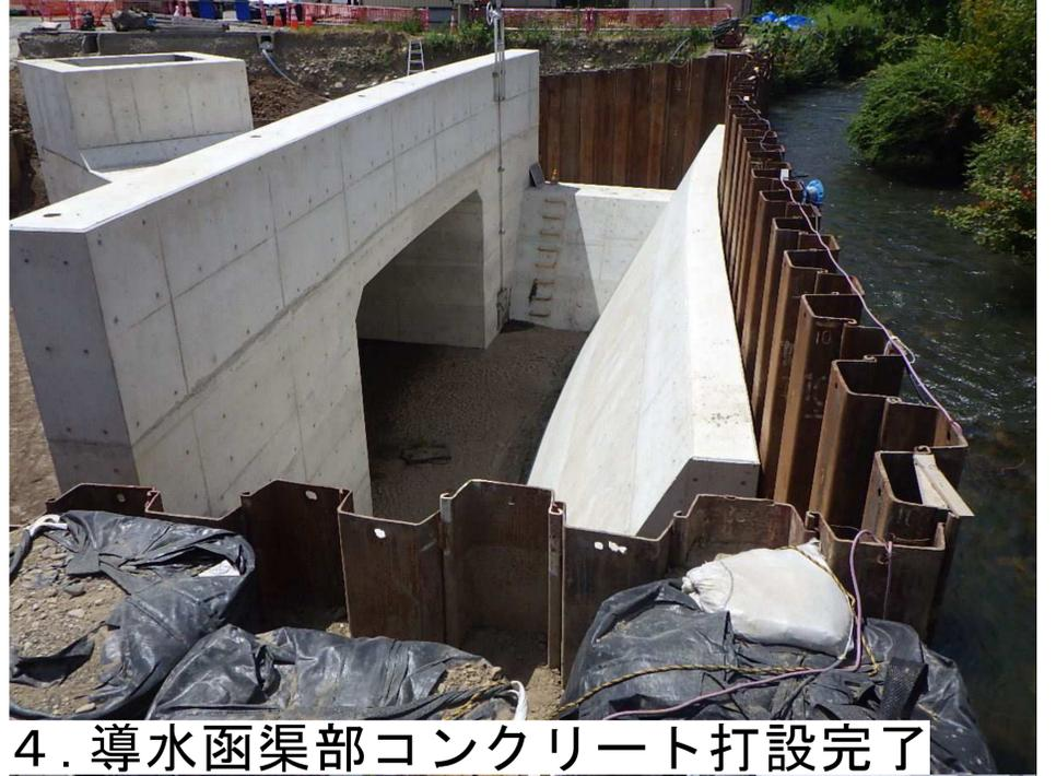
4. 導水函渠部コンクリート打設完了
