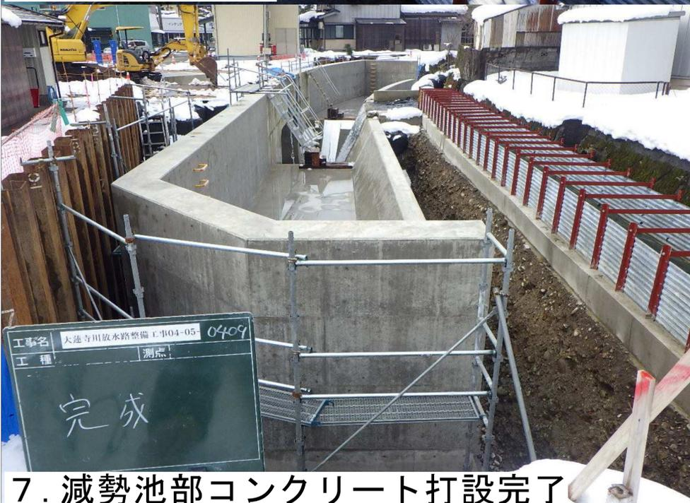
7. 減勢池部コンクリート打設完了
