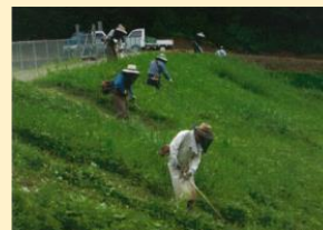
ため池法面の草刈り
