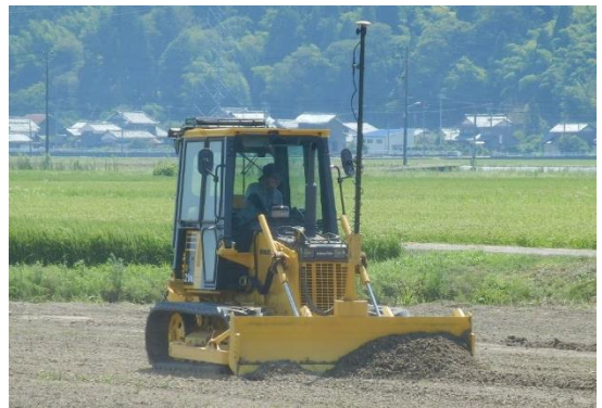
図1 ICTブルの作業風景
