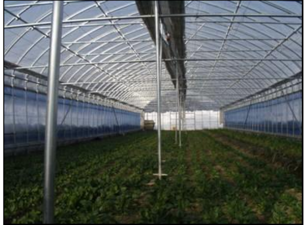
写真3 ハウス内の支柱の設置
