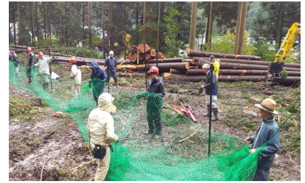
県外大学生とのネット柵設置
