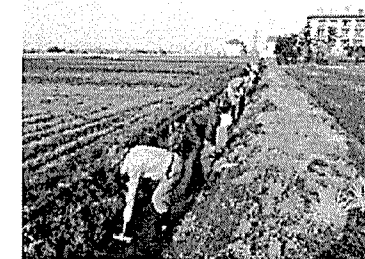
【水路の泥上げ】
