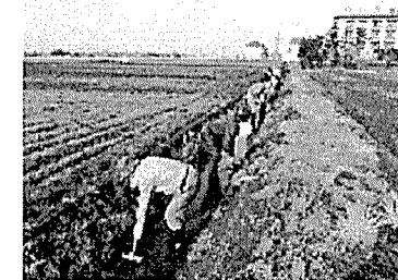
【水路の泥上げ】
