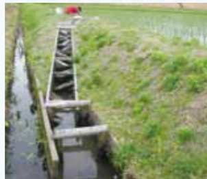
水田魚道の設置(若狭町)
