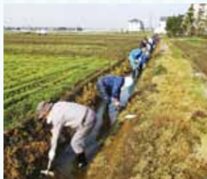
水路の泥上げ
