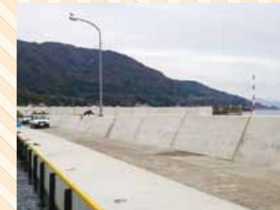
漁港の機能強化（嵩上げと腹付け）（越前漁港）
