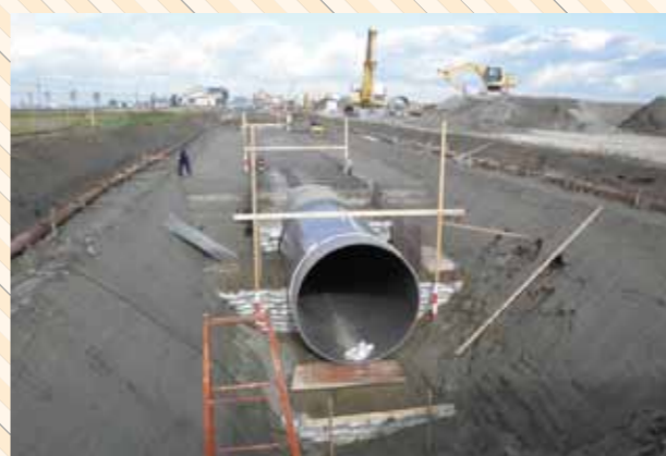
パイプライン整備
