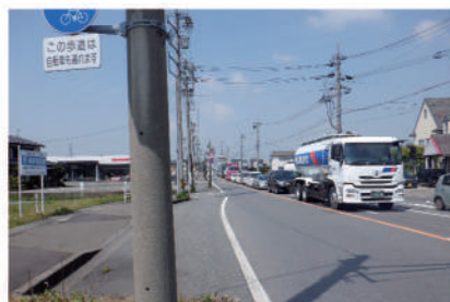
一本田交差点の渋滞状況 (丸岡川西線(現道)と国道8号の交差点)
