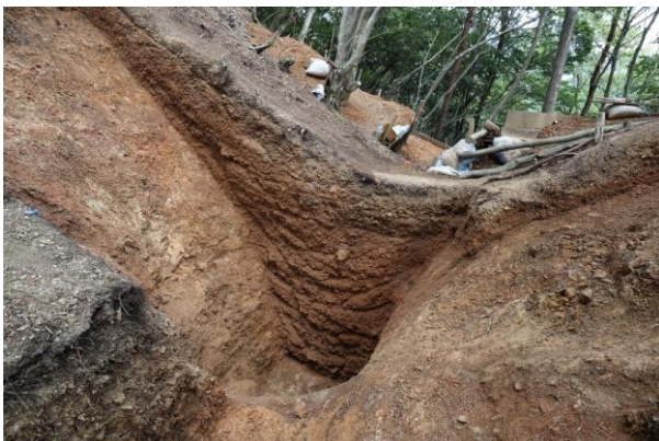
写真3 堆積状況 調査後
