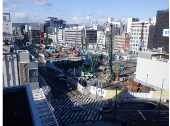
写真1 調査地遠景(ハピリンから)
