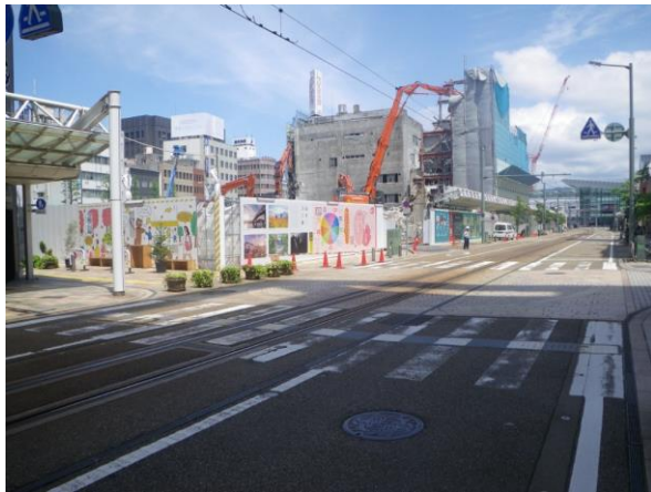
写真2 調査地遠景(福井西武から)
