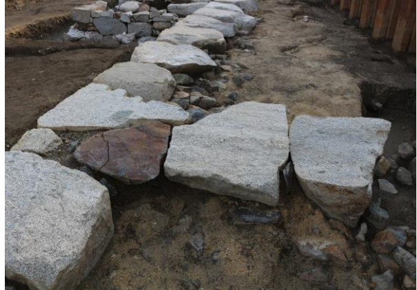
米蔵の仕切り部分の基礎（北から）
