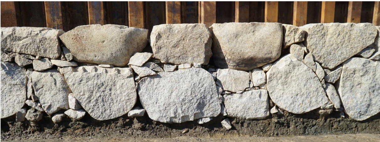
米蔵基礎部石垣（東から）
