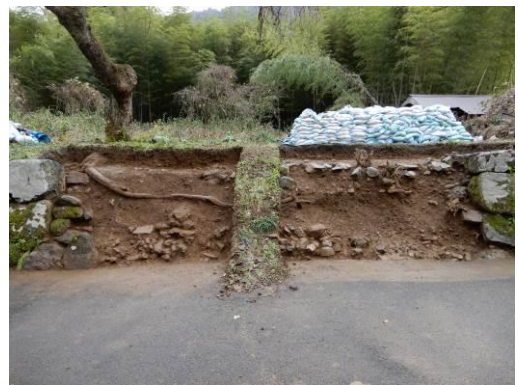
西面石垣欠損部精査状況(西より)
