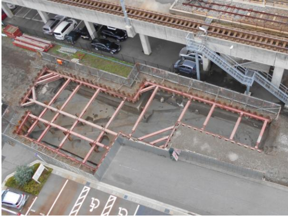
写真1 1区全景(東から)
