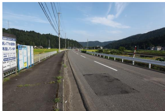
写真2 調査地近景 (南から)
