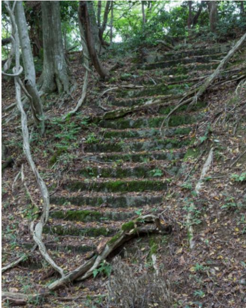
兵舎と射塚を結ぶ階段（調査前）
