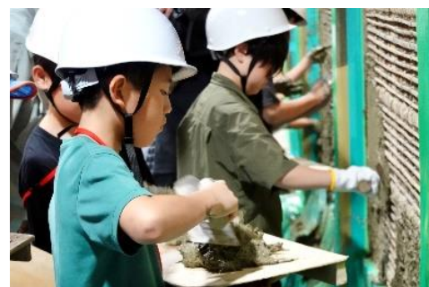
文化財修理イベントの様子(土壁の補修体験)
